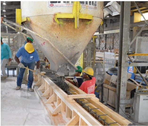
c) Concrete pouring
